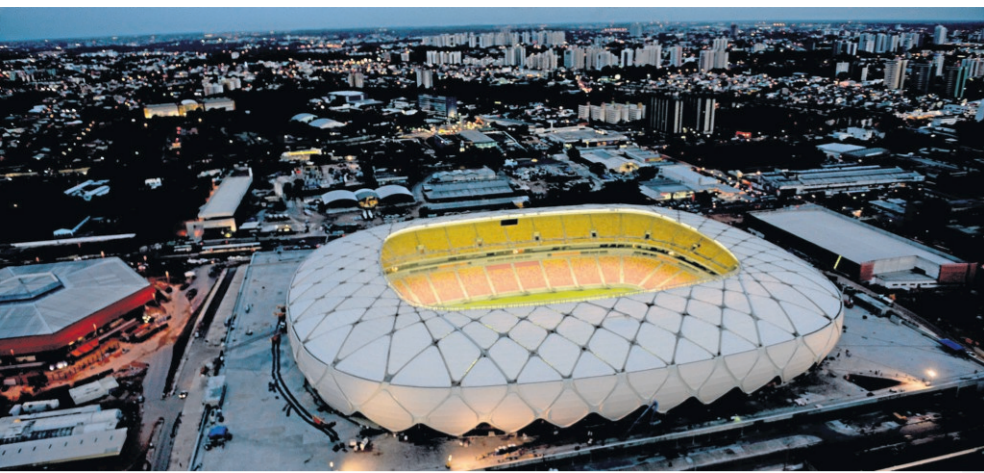
Die Entwurfsgrundlage für die äußere Hülle der neuen Arena da Amazônia wurde in der Natur um Manaus gefunden. Die gebaute Wirklichkeit der Entwurfsidee als rautenförmige Stahlgitterschalenstruktur kann sich sehen lassen und die Assoziationen sind vor allem nachts offensichtlich, wenn die Membranflächen hell erleuchtet sind. Bild: copa2014.gov.org
